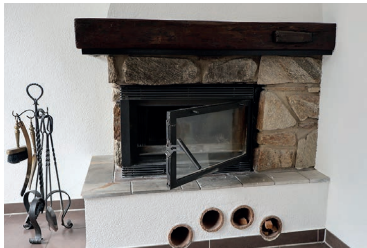
Kamin im Ess- und Wohnzimmer
