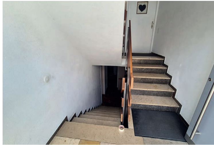
Treppenhaus zum UG und EG
