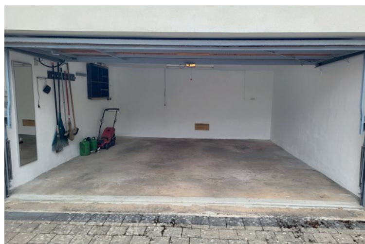
Doppelgarage innen gestrichen 2026
