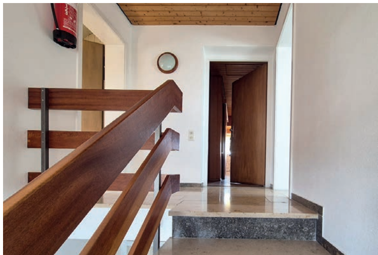
Zugangsbereich zur DG-Wohnung
