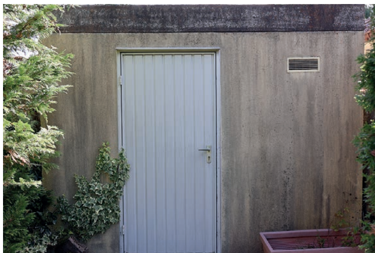
Direkter Zugang zu Garage 2
