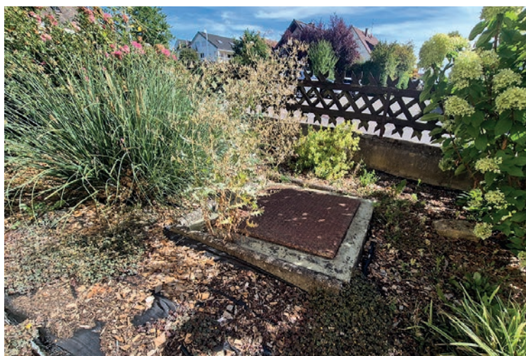
Zugang zum Öltank
