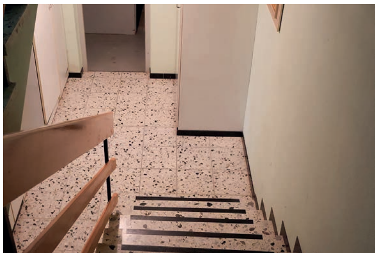
Treppen zum Untergeschoss
