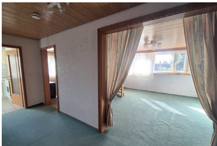
Erster Blick ins DG von der Treppe
