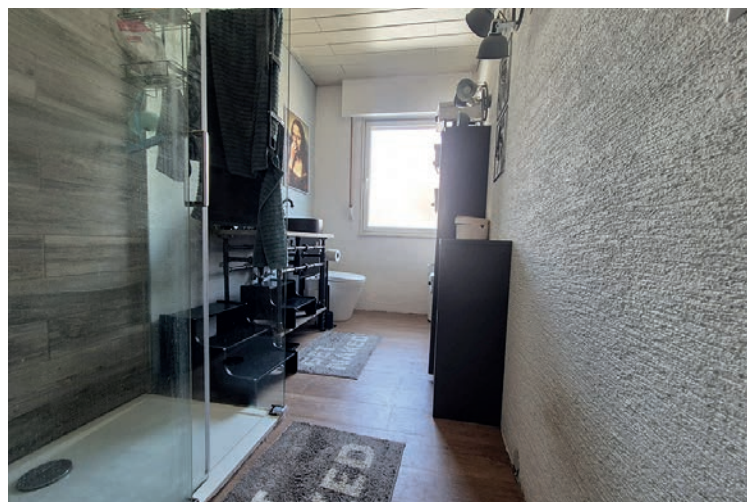
Renoviertes Bad von 2021
