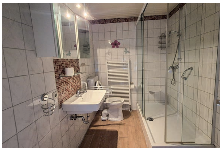
Badezimmer mit Duschkabine im 1. OG
