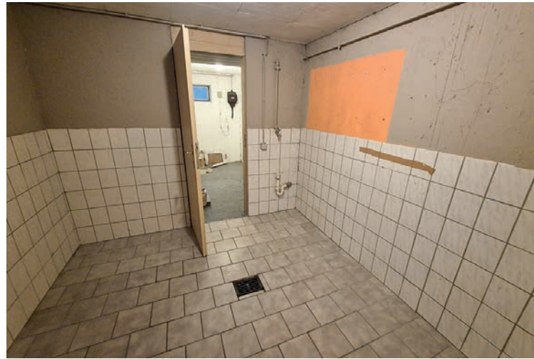
Waschraum in Richtung Abstellraum
