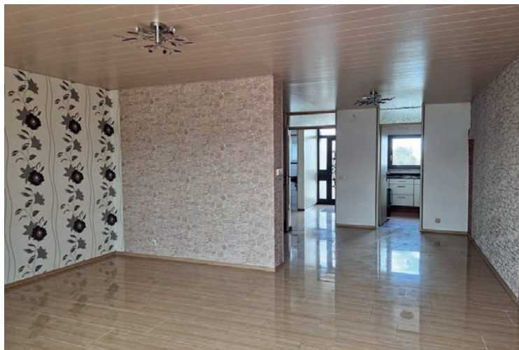
Blick in Richtung Eingang
