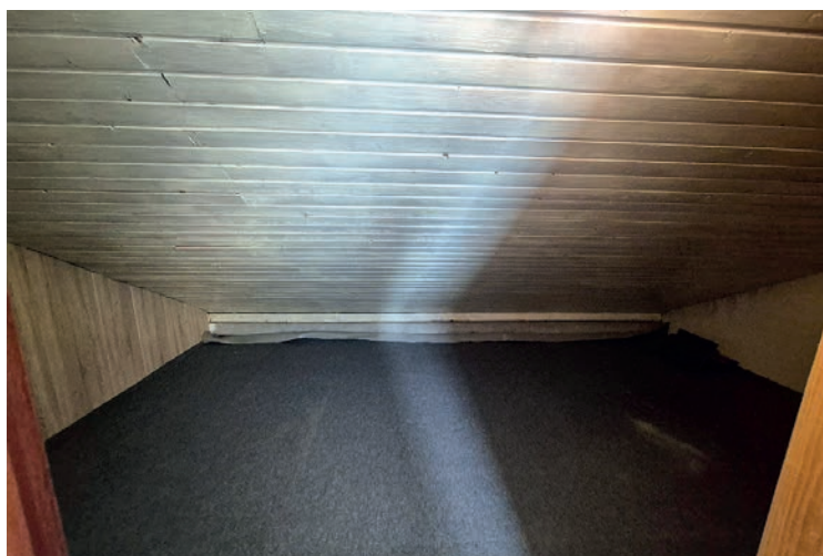
Separater Abstellraum im DG
