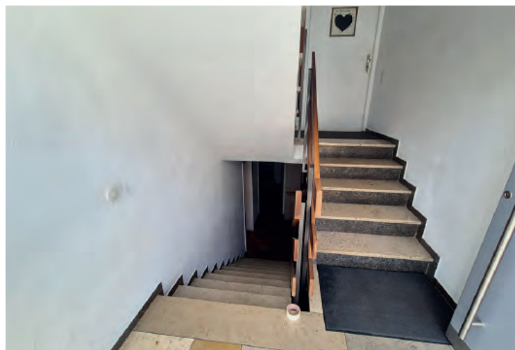
Treppenhaus zum UG und EG
