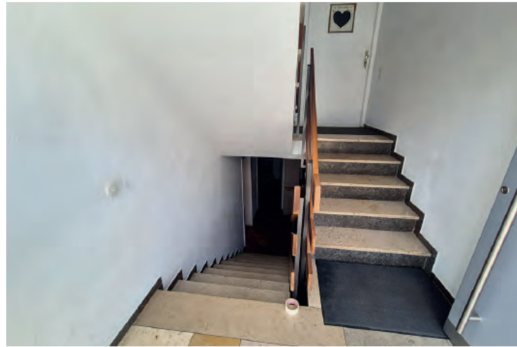
Treppenhaus zum UG und EG
